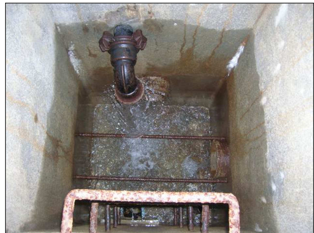
Photo 10 : Intérieur de l'édicule de captage – Chabas (Source : HYDRETTUES le 30 oct. 2013)
