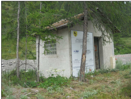
Photo 23 : Local technique (Source : HYDRETUDES le 15 Jul. 2013)
