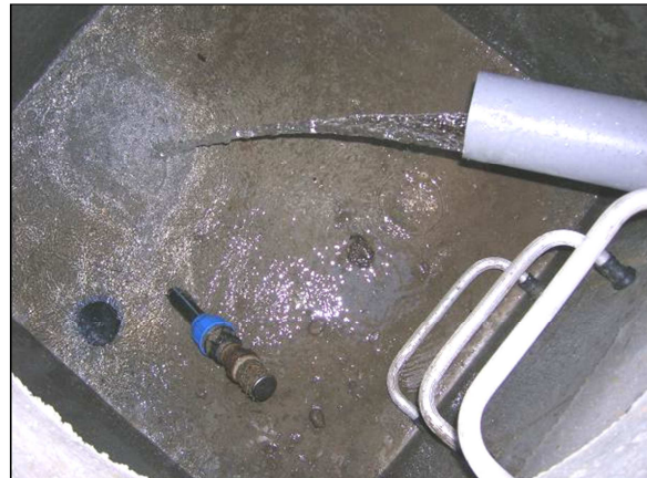
Photo 16 : Intérieur du regard de captage du Varenc (Source : HYDRETTUES le 29 sept. 2011)
