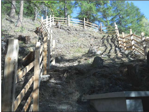
Photo 3 : Aspect extérieur du captage –Mounal 2 (Source : HYDRETTUES le 6 oct. 2011)
