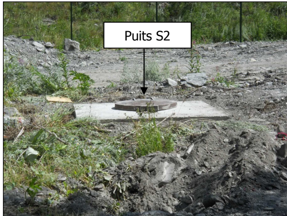
Photo 21 : Environnement extérieur du puits S2 (Source : HYDRETUDES le 13 Jul. 2013)
