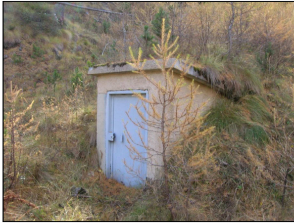
Photo 7 : Aspect extérieur du captage – Clôt Besseys (Source : HYDRETTUES le 30 oct. 2013)
