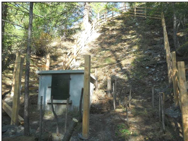
Photo 5 : Aspect extérieur du captage - Mounal 3 (Source : HYDRETTUES le 6 oct. 2011)
